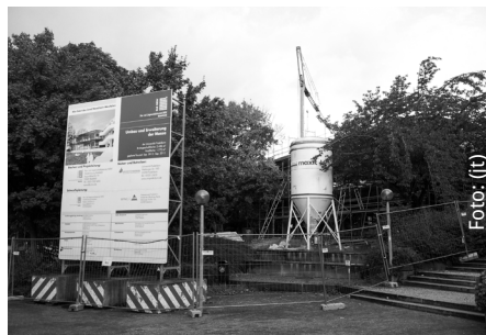
Vermutlich bis Januar 2014 eine Baustelle
